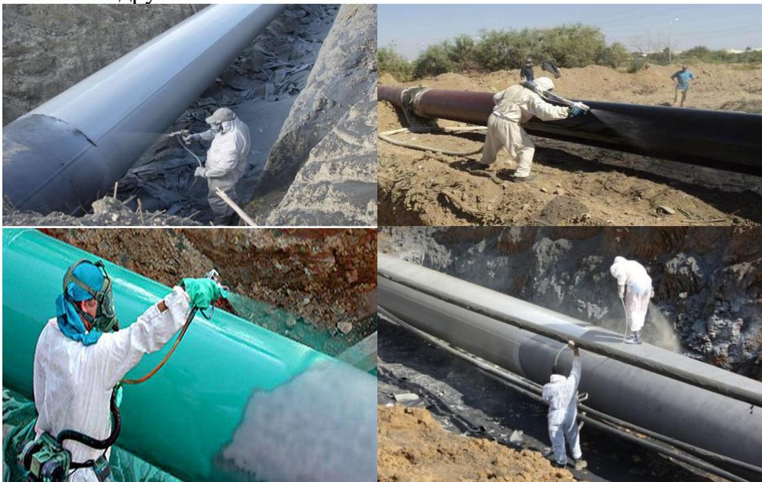
**Рис. 3. Лакокрасочные покрытия для защиты труб от коррозии.**
