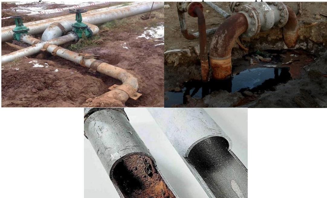
**Рисунок 1. Коррозия труб.**
