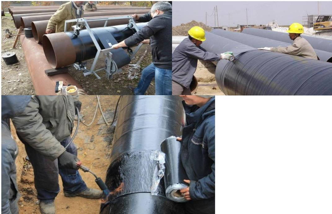
**Рисунок 4. Полиэтиленовое покрытие труб для защиты от коррозии.**
